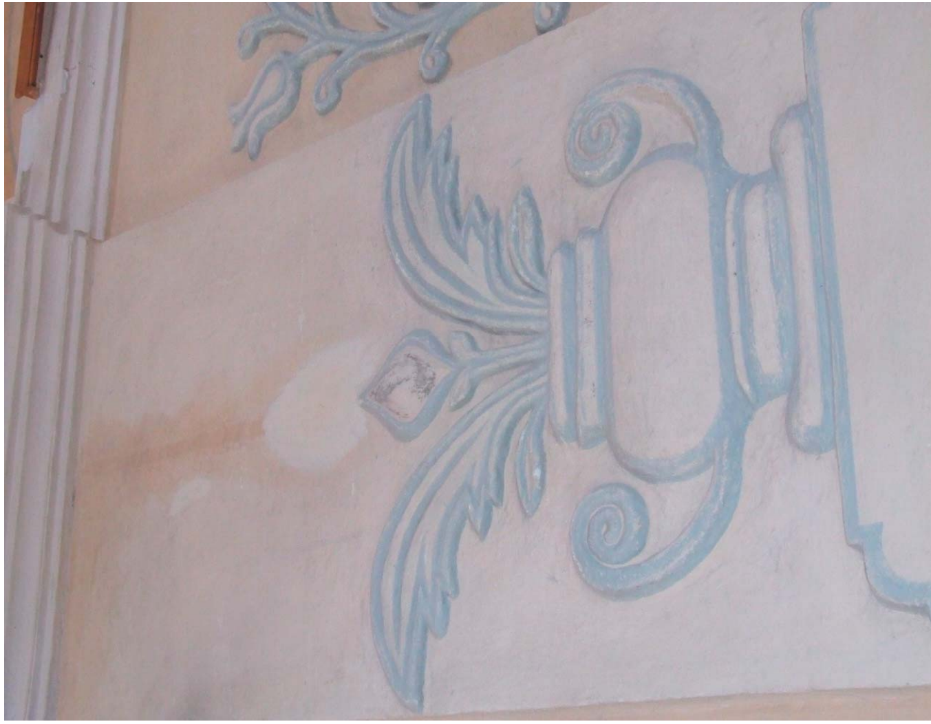
Evanjelický a.v. kostol v Hybiach - pohľad na zostárnutú maľbu a zavlhnutú pätku stúpa
