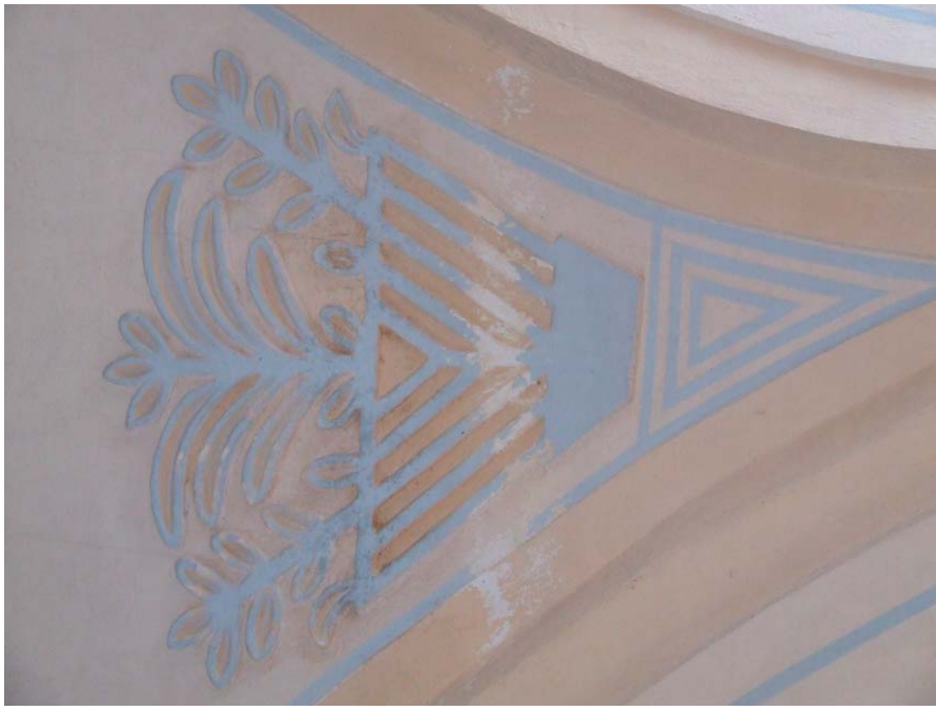
Evanjelický a.v. kostol v Hybiach - pohľad na omietku a výzdobu poškodenú dažďom
