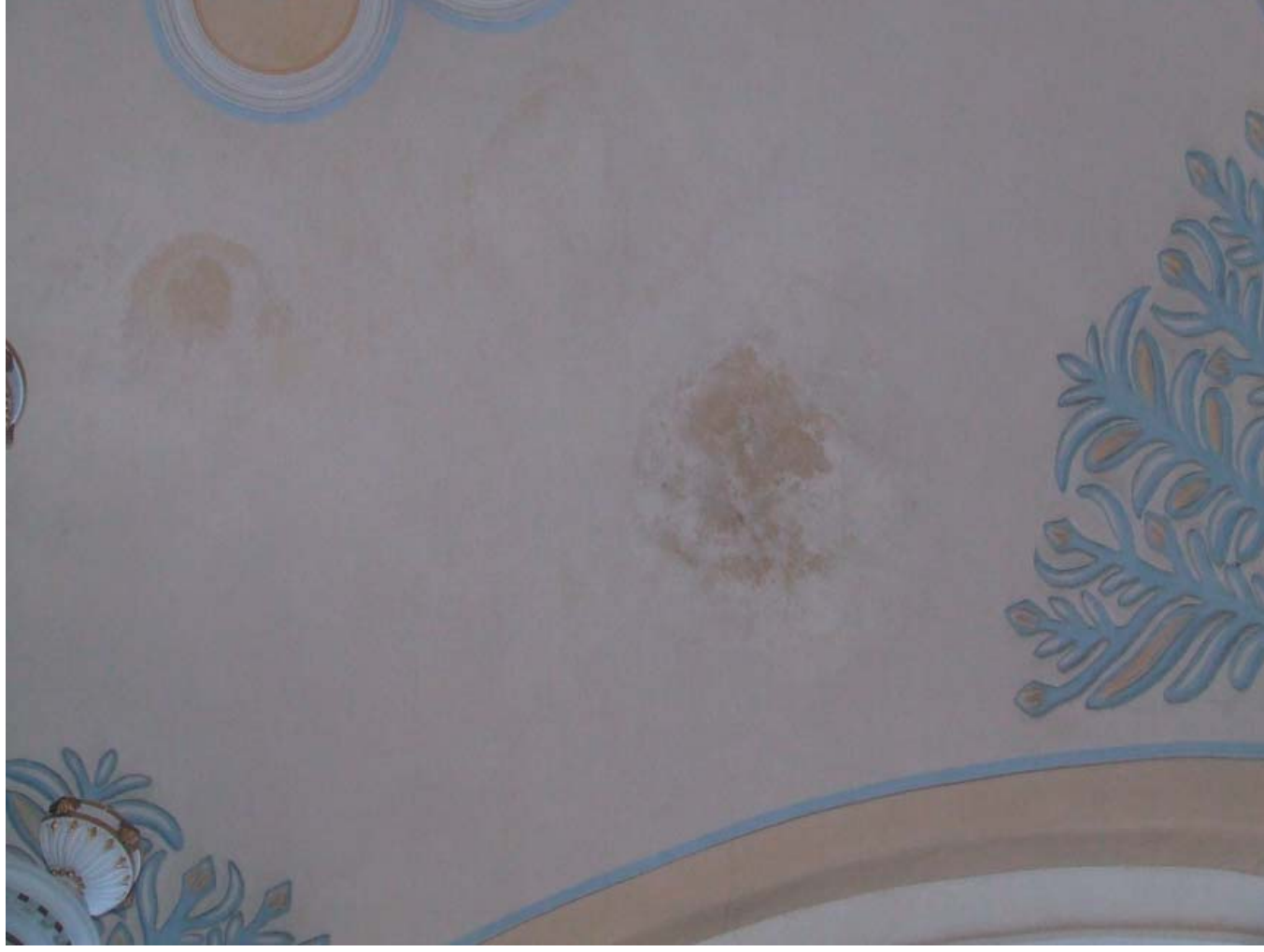
Evanjelický a.v. kostol v Hybiach - pohľad na omietku a výzdobu poškodenú dažďom
