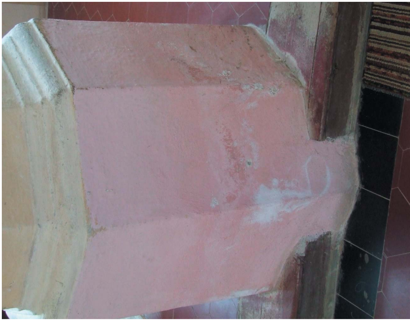
Evanjelický a.v. kostol v Hybiach - pohľad na zostárnutú maľbu a zavlhnutú pätku stúpa
